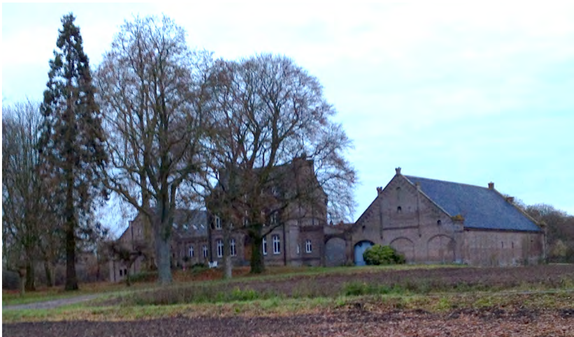
Hitzfeldhof, große Hofanlage mit mehreren Scheunen mit Satteldächern (gebaut 1858).
