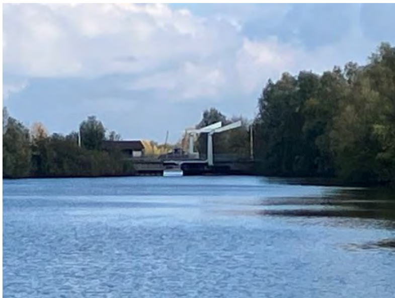
Klappbrücke am Ortseingang Wardt
