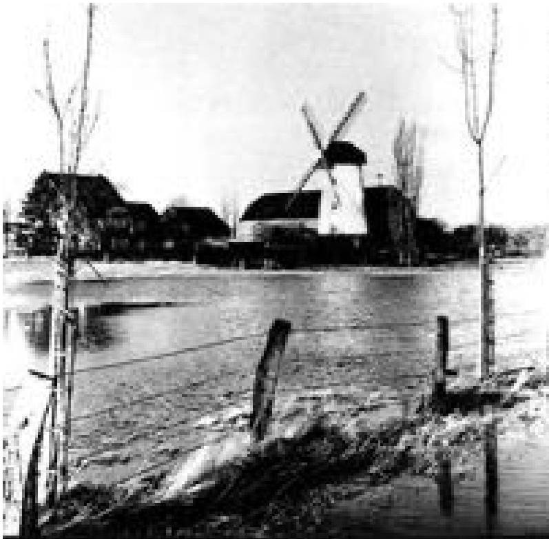
Harderingsmühle, Hochwasser am Bruckend
