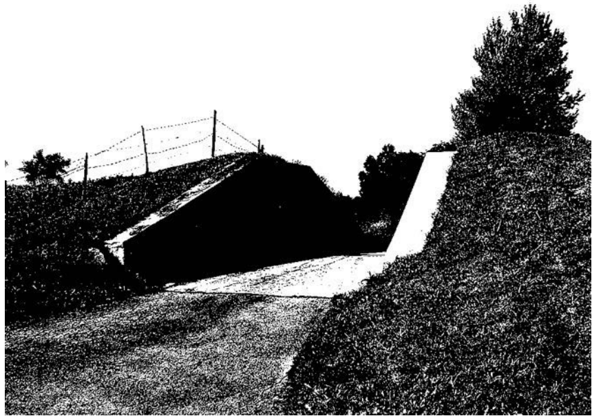
Verschließbarer Deichdurchgang
