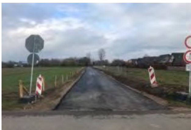
Temporäre Deichbaustraße in Wardt
