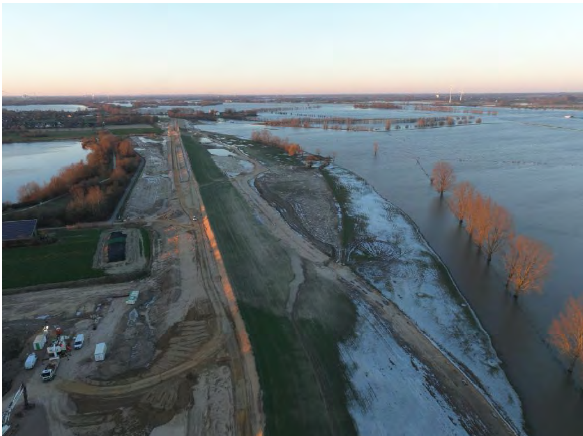
Deichbaustelle während der Hochwasser im Winter 2023/24
