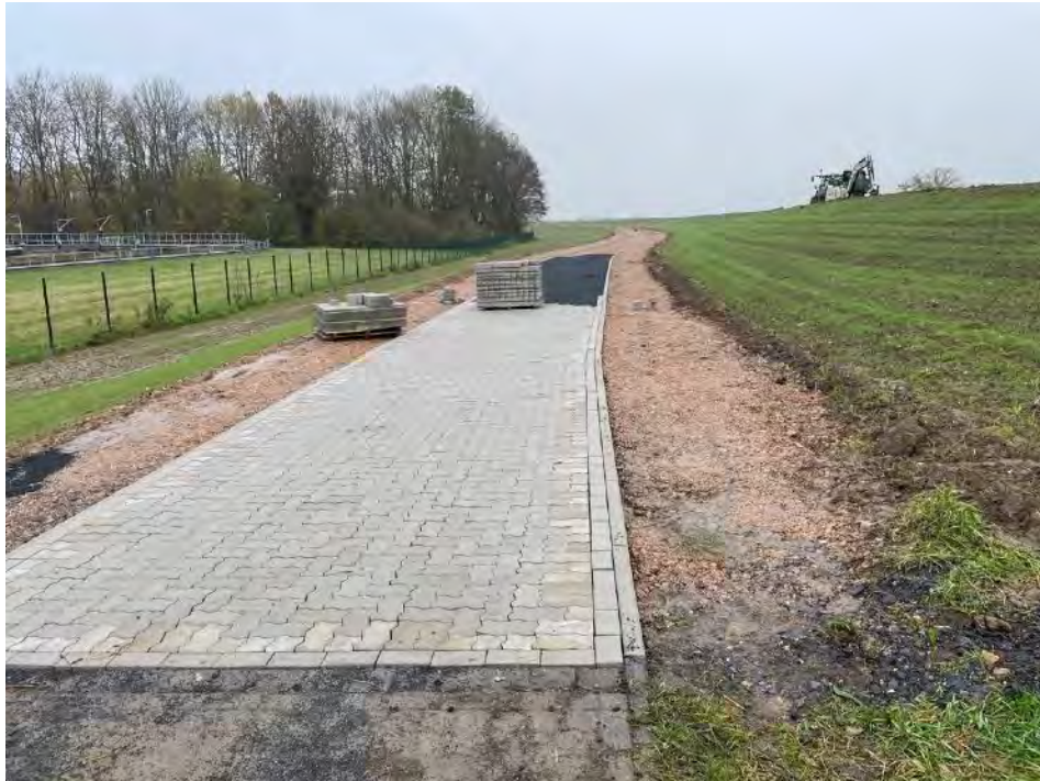
Pflasterarbeiten auf dem Deichverteidigungsweg
