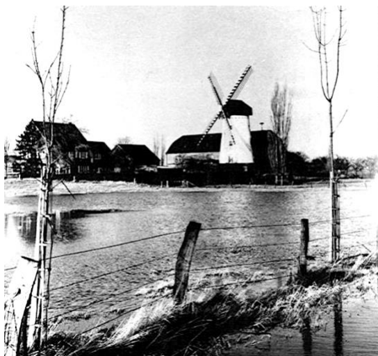
Hochwasser am Bruckend
